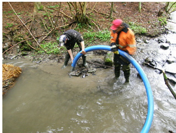
Abb. 6: Ökolog. Baubegleitung: Abpumpen des bei einer Baumaßnahme aufgefangenen Sediments
