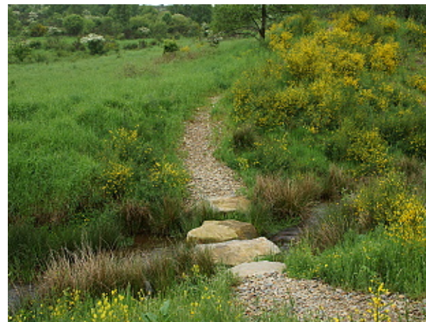
Abb. 12: Ersatz einer Verrohrung durch „Trittschnecken“
