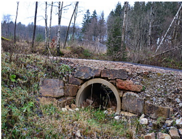
Abb. 15: Ersatz einer nicht passierbaren Verrohrung durch größlumigere Rohre mit Sediment
