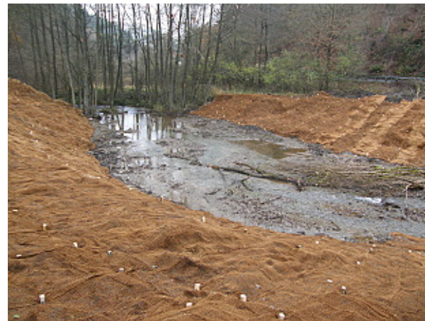
Abb. 23: Sicherung bodenoffener Böschungflächen durch „Kokosmatten“: Schutz vor Eintrag von Feinsediment in das Gewässer
