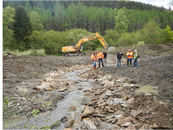
Abb. 17: Während der Baumaßnahmen zum Rückbau des Sedimentationsbeckens am „Gierbach“
