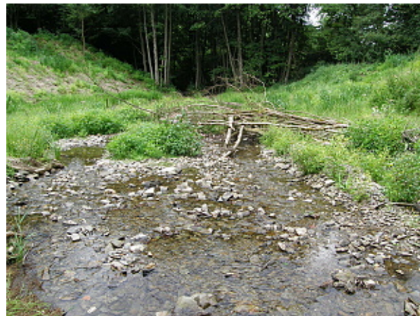
Abb. 19: Bildung gewässertypischer Strukturen, ein Jahr nach dem Rückbau des Sedimentationsbeckens am „Sauerbach“
