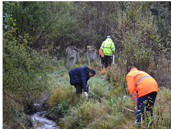
Abb. 4: Massenermittlung mit Baufirma und Ingenieurbüro
