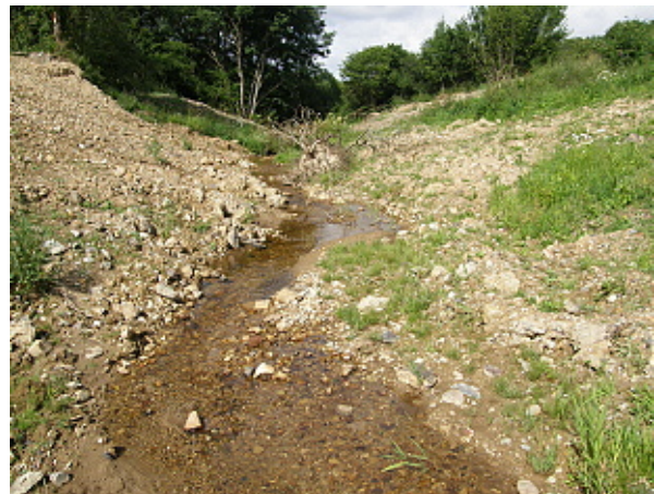
Abb. 14: Ersatzlose Entnahme einer Verrohrung
