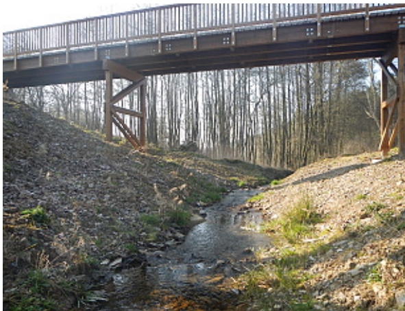
Abb. 13: Ersatz einer Verrohrung durch eine für Wanderer, Fahrradfahrer, Reiter und PKW passierbare Brücke
