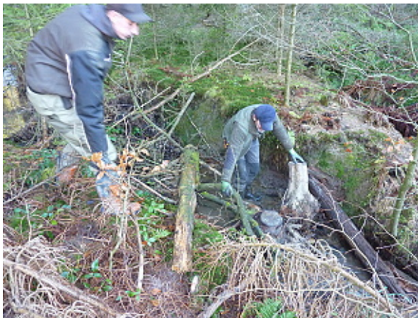
Abb. 24: Einbau von Totholz
