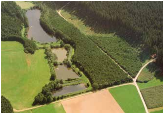
Abb. 1.: Erste EBS-Teichanlage im Bernbachtal
